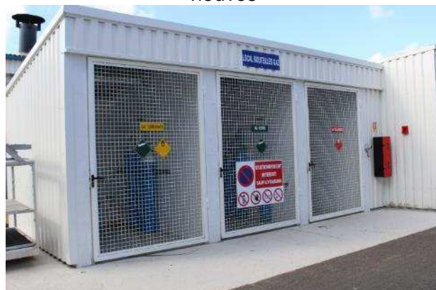
Bâtiment de stockage des bouteilles de gaz neuves
